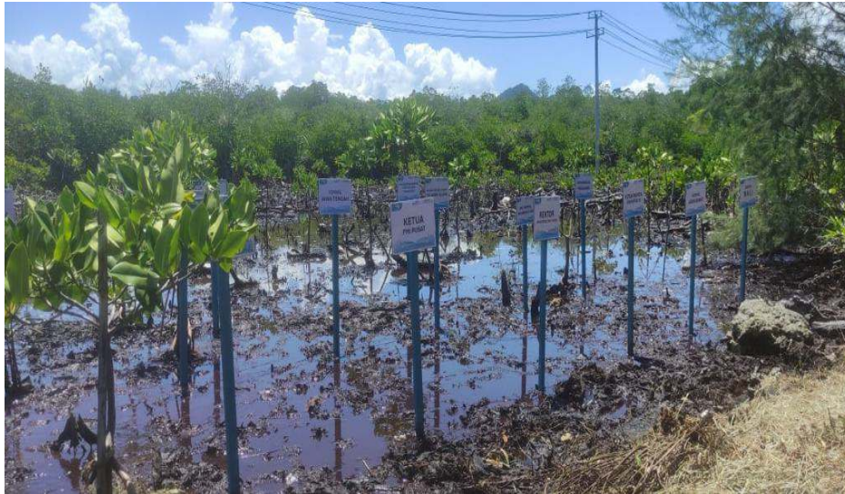
Gambar 6. Lokasi penanaman dan pemasangan ajir
