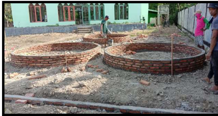
Gambar 1. Pembuatan Kolam
