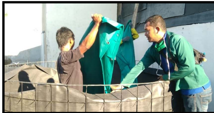
Gambar 2. Proses pemasangan Terpal
