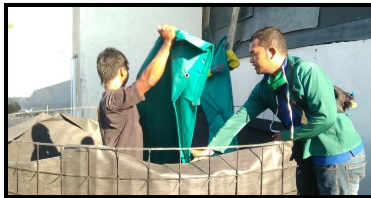
Gambar 2. Proses pemasangan Terpal
